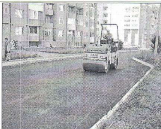
Асфальтирование дворовых проездов
