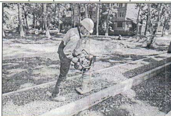
Устройство (ремонт) тротуаров
