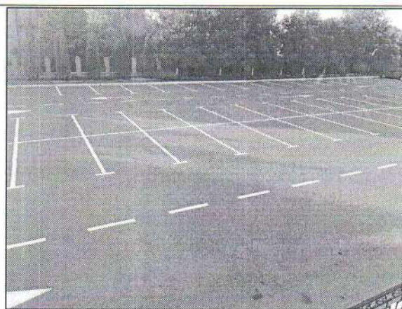
Устройство парковочных пространств
