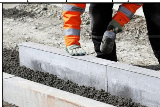
Установка или замена бордюрного камня
