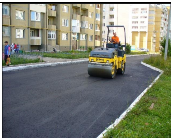
Асфальтирование дворовых проездов
