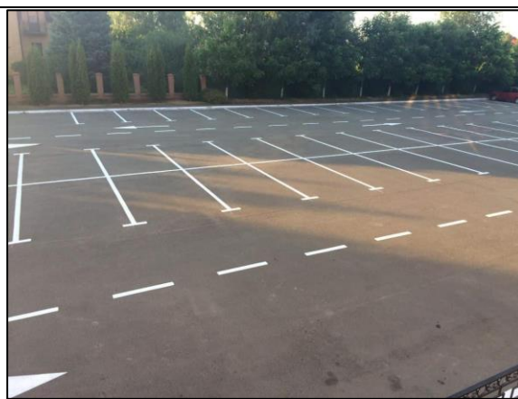
Устройство парковочных пространств
