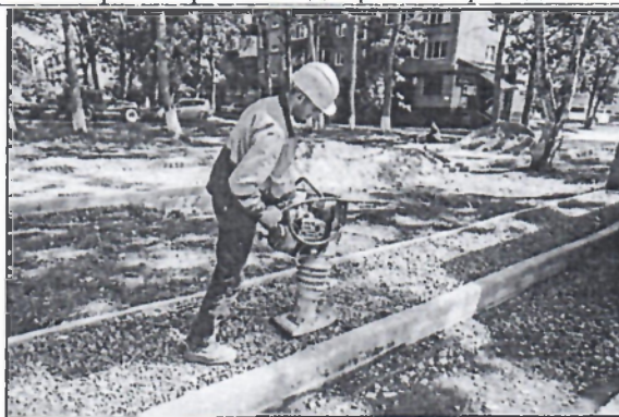
Устройство (ремонт) тротуаров
