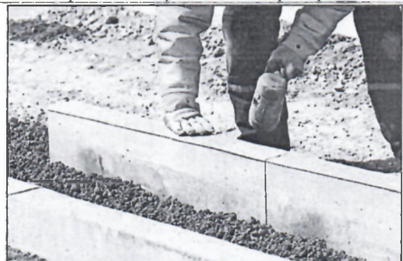
Установка или замена бордюрного камня
