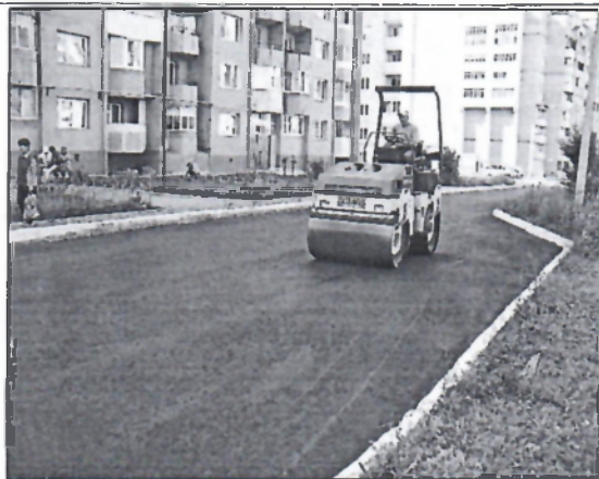
Асфальтирование дворовых проездов
