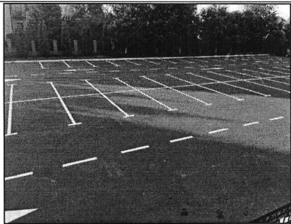
Устройство парковочных пространств
