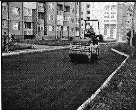
Асфальтирование дворовых проездов
