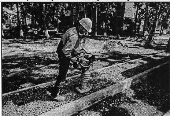
Устройство (ремонт) тротуаров
